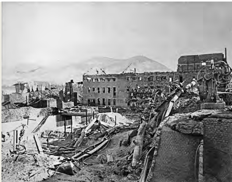
ROHMÜHLENGEBÄUDE nach dem Brand, Februar 1895.
