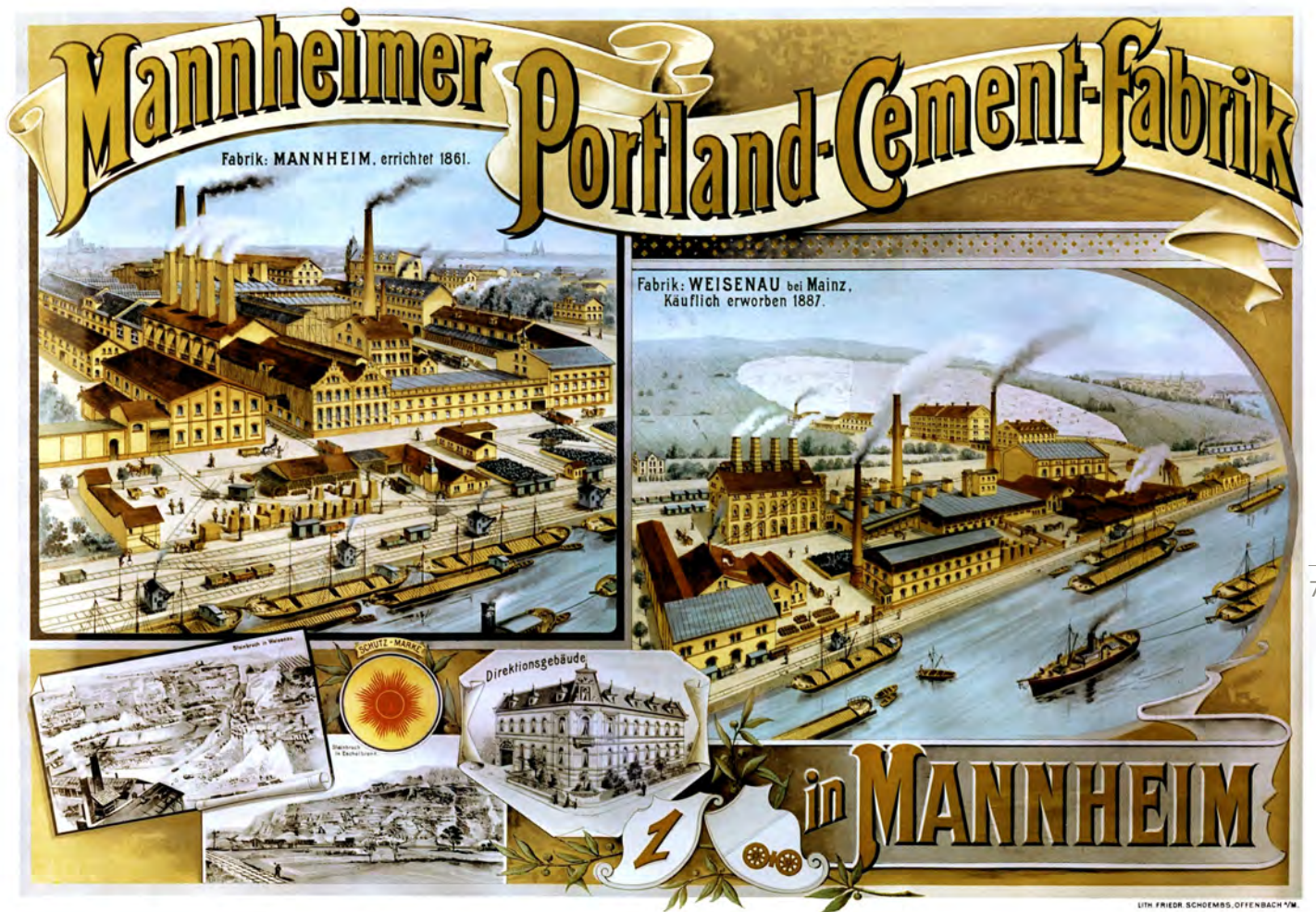
MANNHEIMER PORTLAND-CEMENT-FABRIK nach dem Mannheimer Werksumbau und Erwerb des neuen Zweigwerks in Weisenau bei Mainz, 1890.
